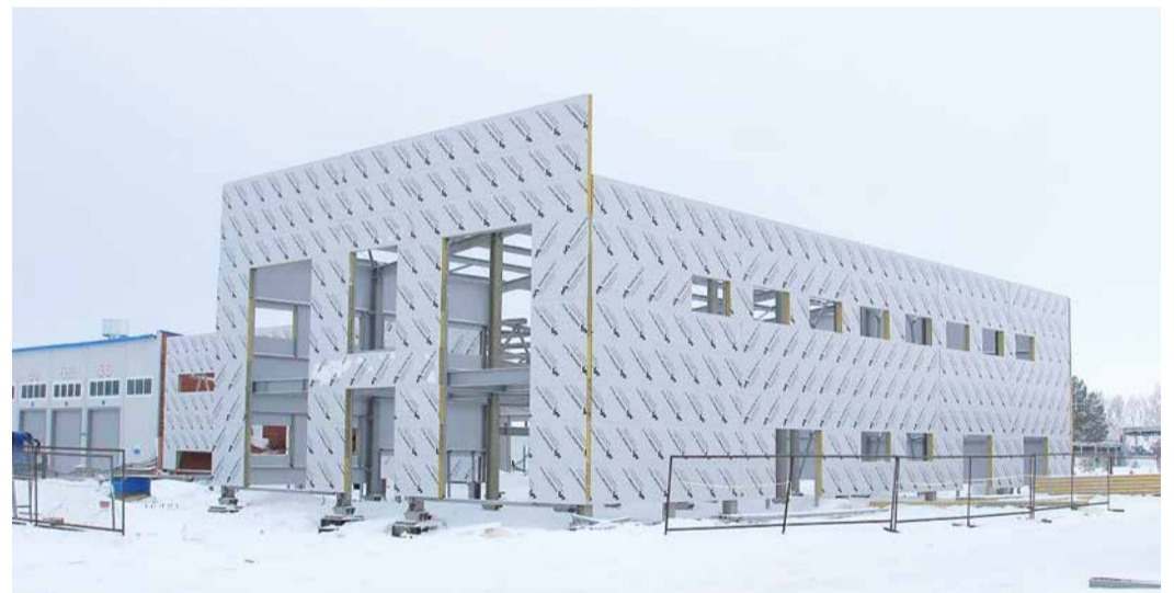
Строительство здания АБК и участка ТОиТР
