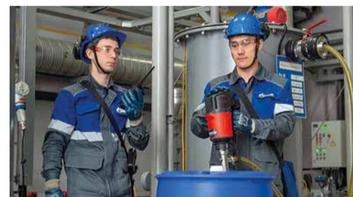
Реагенты добавляют в питательную и котловую воду для устранения неблагоприятных явлений
